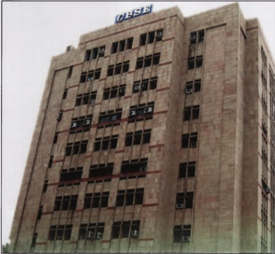
सीबीएसई मुख्यालय / CBSE Head Office
