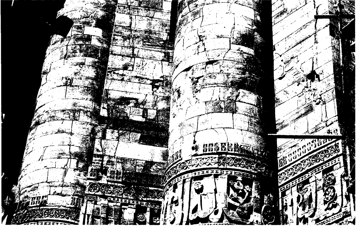
संरक्षण-कार्य के पूर्व, कुतुबमीनार, दिल्ली में बलुआ पत्थर की उभरी हुई लम्बी धारियां Bulged sand stone flutings of Qutb Minar, Delhi – Before Conservation
