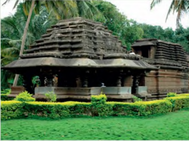
Kamala Basti, Belagavi
