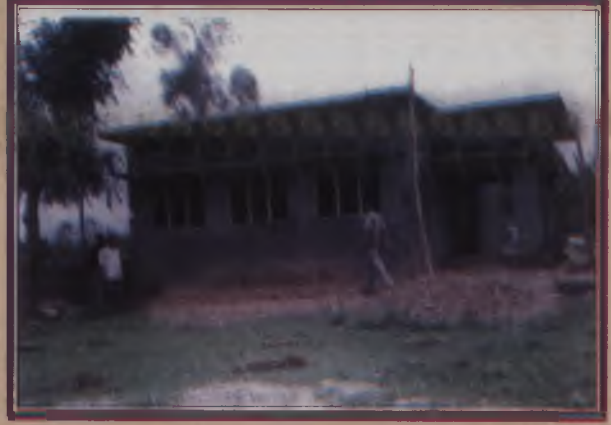
निर्माणाधीन प्राथमिक विद्यालय भवन
