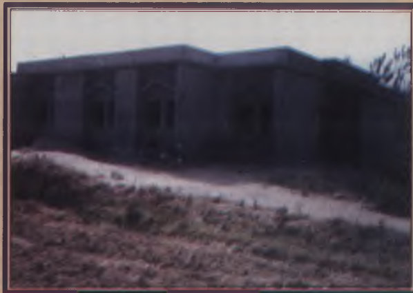
निर्माणाधीन उच्च प्राथमिक विद्यालय भवन
