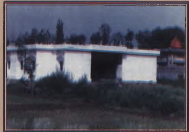
निर्माणाधीन उच्च प्राथमिक विद्यालय भवन
